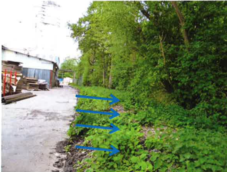
Écoulements des eaux de voiries vers l'Andelle et infiltration
